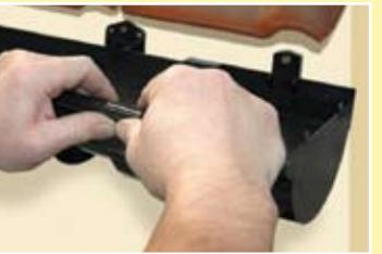
Зафиксируйте желоб в соединителе и воронке.
