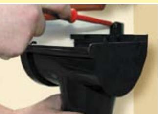
Закрепите соединитель желоба и воронку на стене, также учитывая наклон 3 мм.
