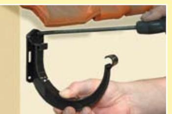
Закрепите крайние кронштейны с учетом наклона 3 мм по направлению слива.
